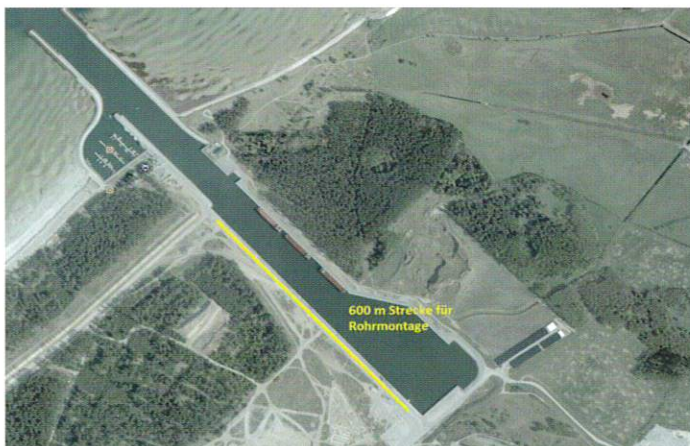
Abb. 11: Der Rohrstrang an Land vorgestreckt und verschweißt ... | Foto: Beermann Bohrtechnik GmbH
