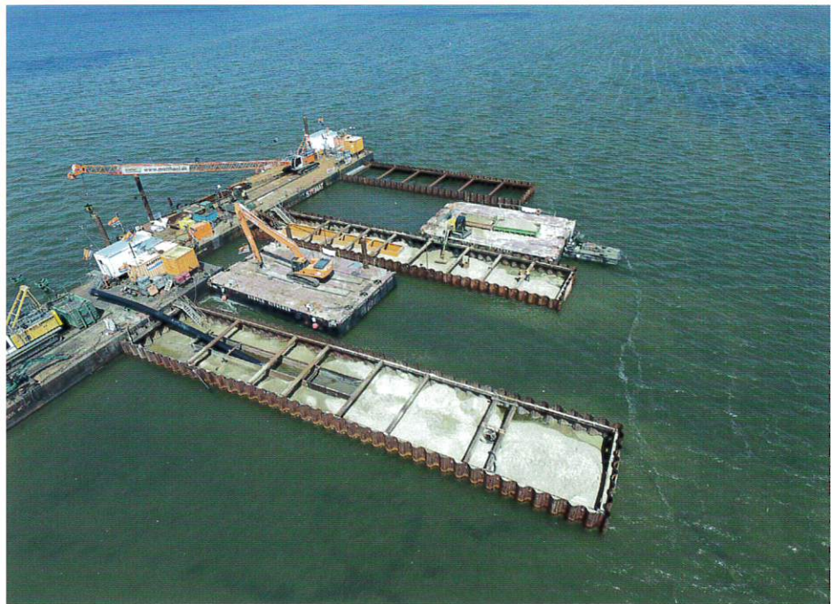
Abb. 6: Baugrubenumschließung der im Greifswalder Bodden liegenden Bohraustrittspunkte. | Foto: Beermann Bohrtechnik GmbH
