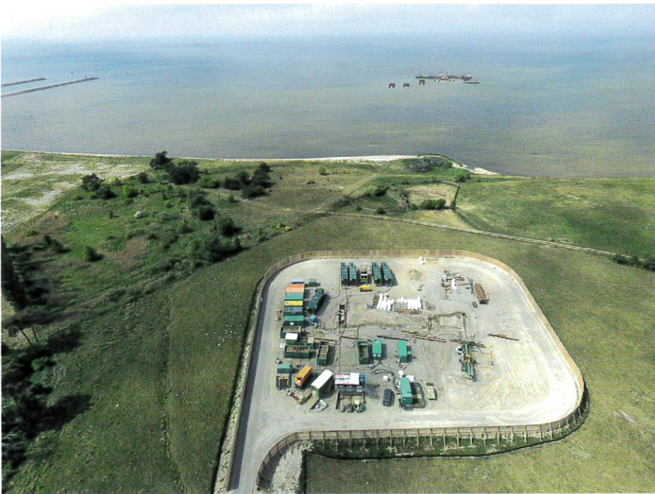
Abb. 8: Baufeld A | Foto: Beermann Bohrtechnik GmbH
