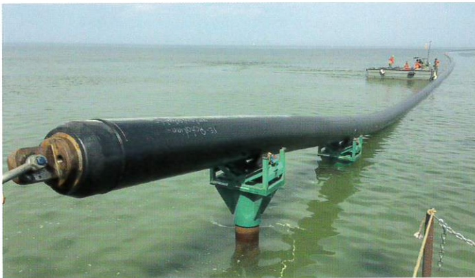
Abb. 13/14: Einzug des ballastierten Rohrstranges. | Foto: Beermann Bohrtechnik GmbH
