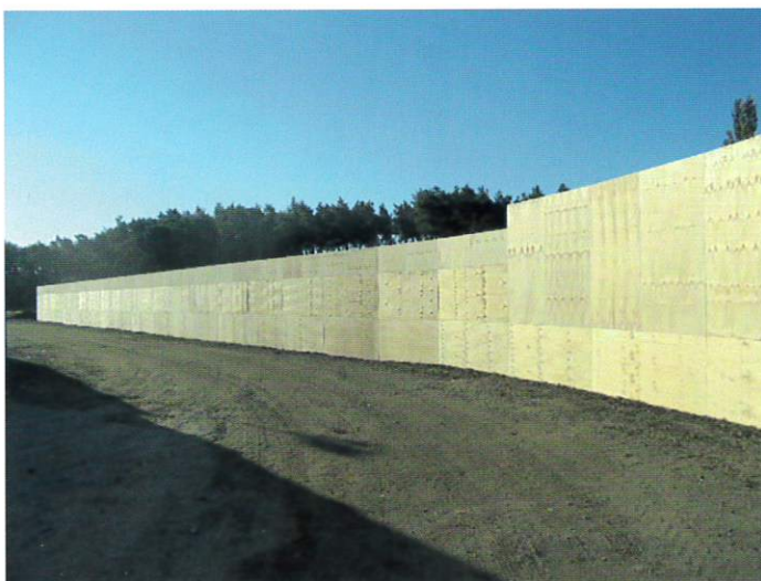
Abb. 4: Aufstellen von Sichtschutzwänden für optisch empfindliche Vogelarten. | Foto: Beermann Bohrtechnik GmbH
