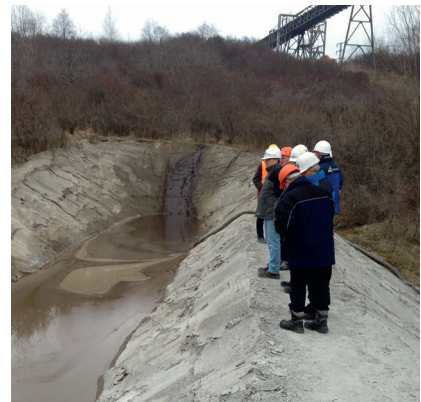
▲ Abb. 3 – Geplant war ein Spüldamm im Austrittsbereich, um den Suspensionspegel oberhalb des Grundwasserspiegels des zu verfilternden Grundwasserleiters zu halten.
