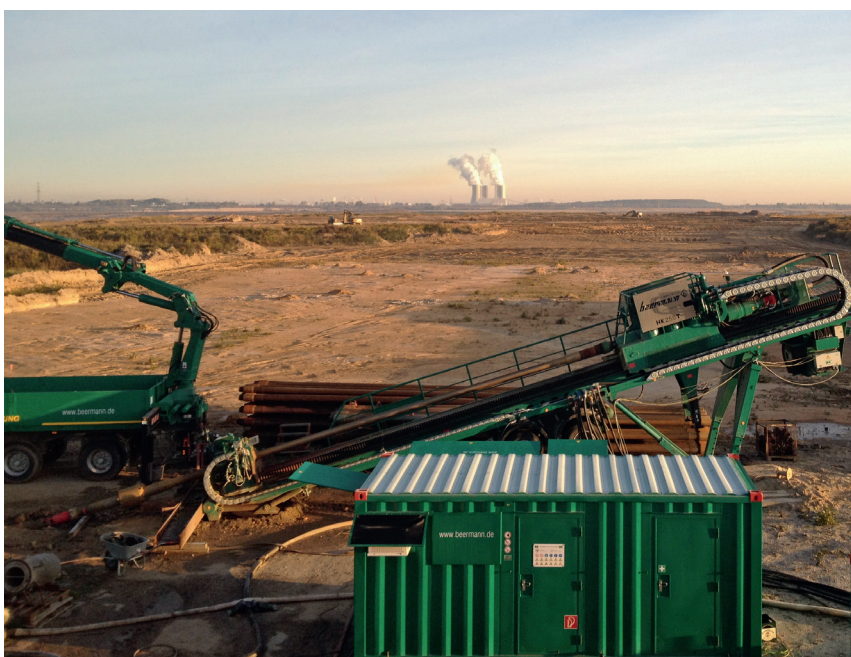
Abb. 8 – Den Ein- und Wiederausbauvorgang des Stahlträgerrohres bewältigte die 250-t Großbohranlage.
