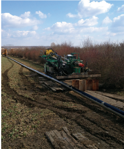
Abb. 6 – Da der Ausbau des Trägerrohres reibungslos gelang, war der Einsatz der Bohranlage nicht erforderlich.
