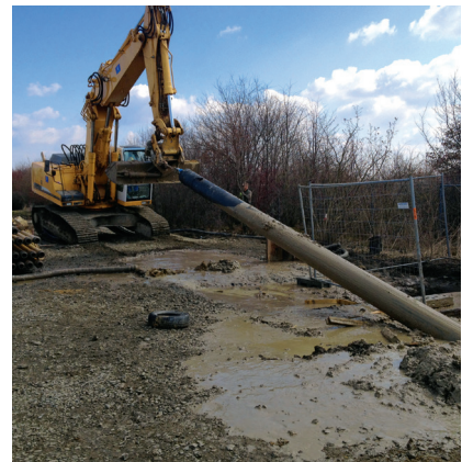
▼ Abb. 5 – Ziehen des Trägerrohres in Richtung Hochpunkt mittels Kettenbagger
