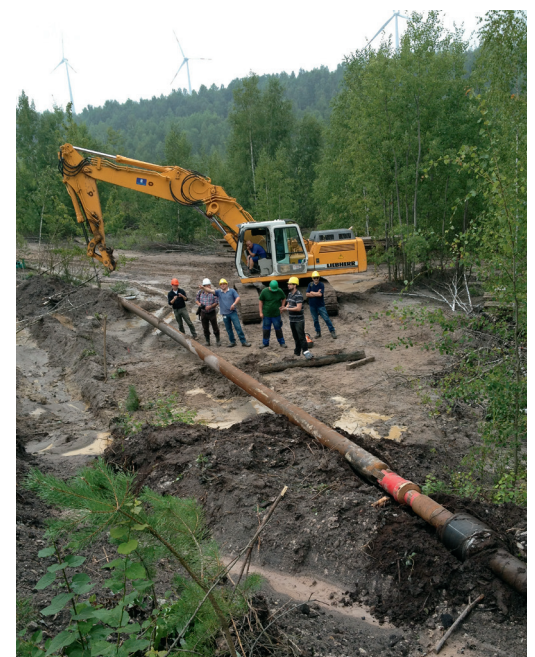
Abb. 9 – Einzug des Trägerrohres von der Böschungunterkante in das Bohrloch
