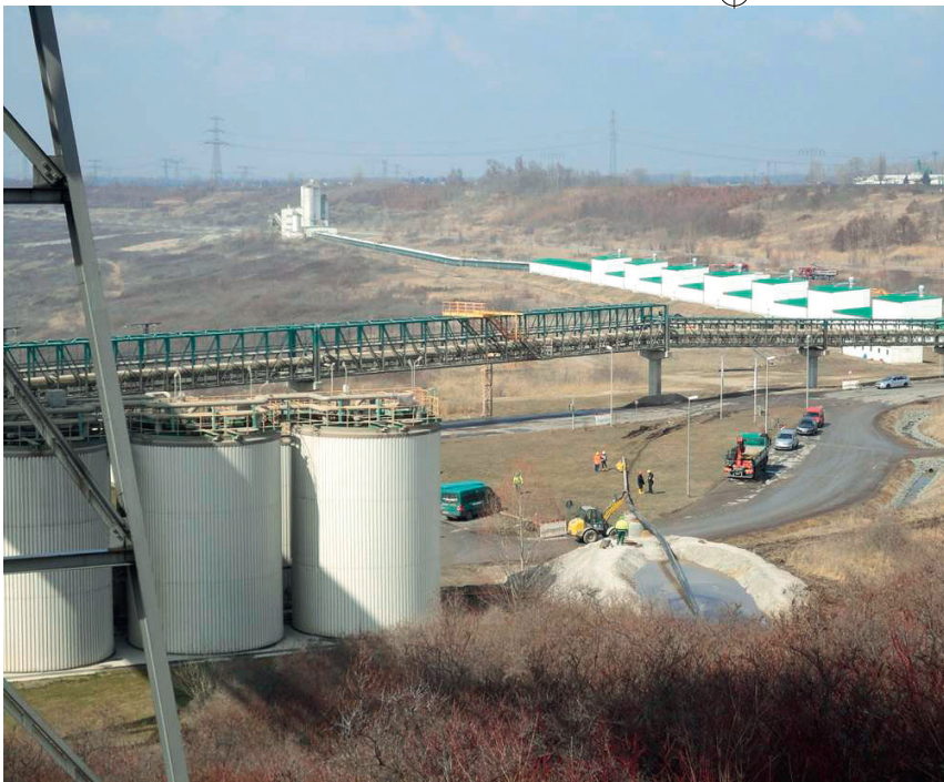
◀ Abb. 2 – Zwischen Bohreintritt und -austritt bestand ein deutlicher Höhenunterschied.
