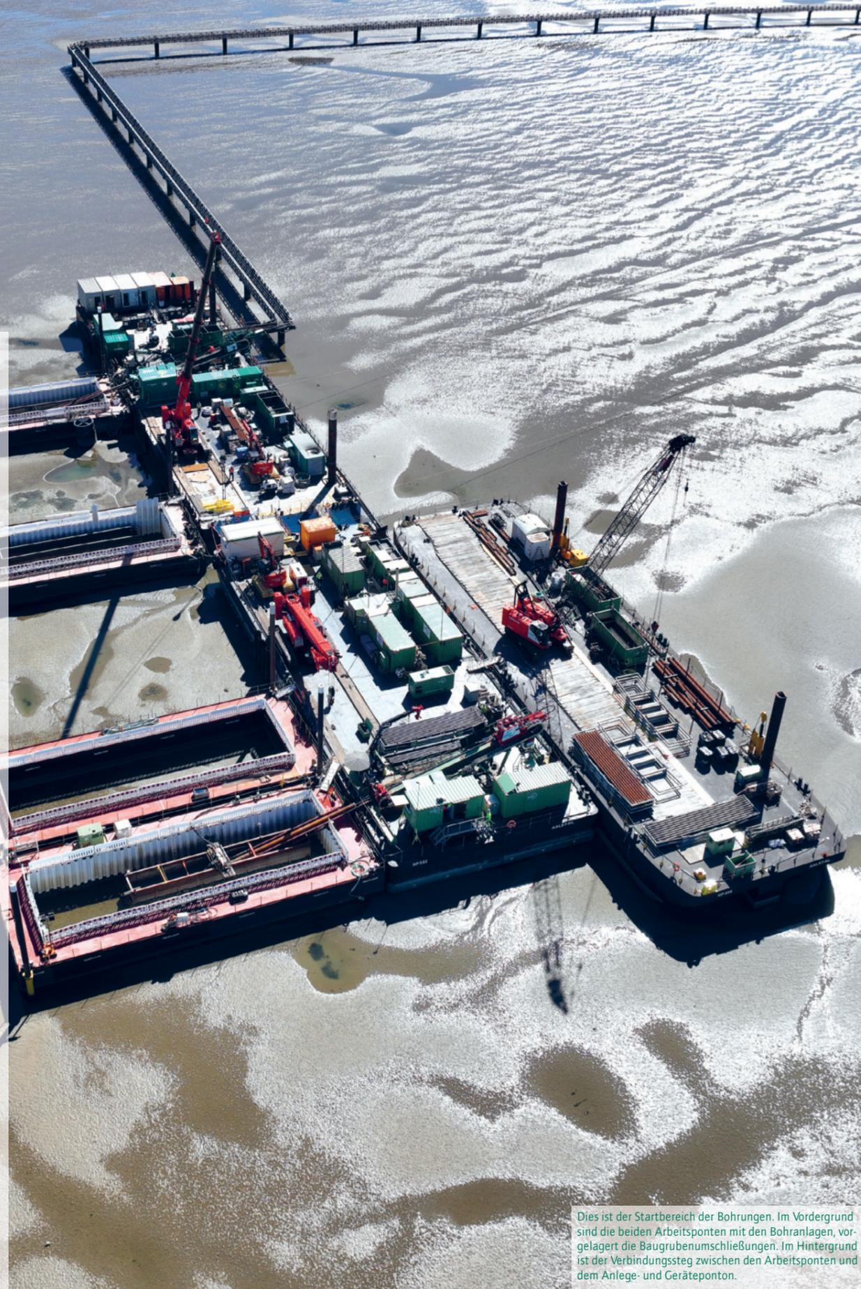
Dies ist der Startbereich der Bohrungen. Im Vordergrund sind die beiden Arbeitspontons mit den Bohranlagen, vorgelagert die Baugrubenumschließungen. Im Hintergrund ist der Verbindungssteg zwischen den Arbeitspontons und dem Anlege- und Geräteponton.
