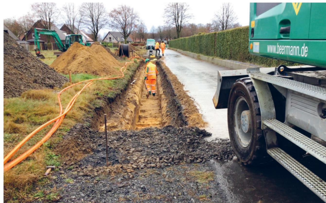
Graben für die Mehrfachverlegung der Leerrohre für Glasfaseranbindungen
