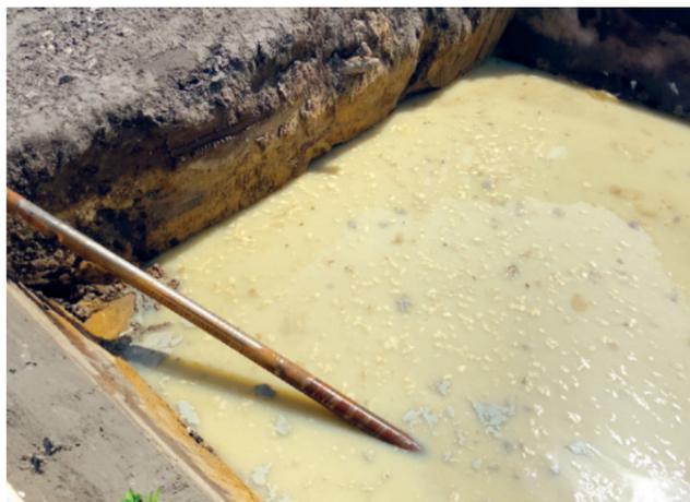
Startgrube mit Bohrspülung
