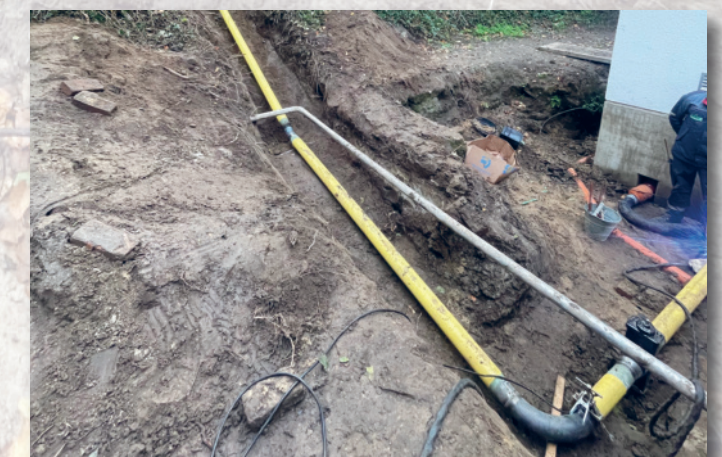
Gasanschlussleitung aus Stahl für die Übergabestation
