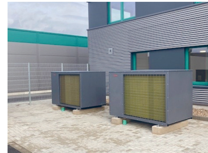
Die Luft-Wasser-Wärmepumpen
