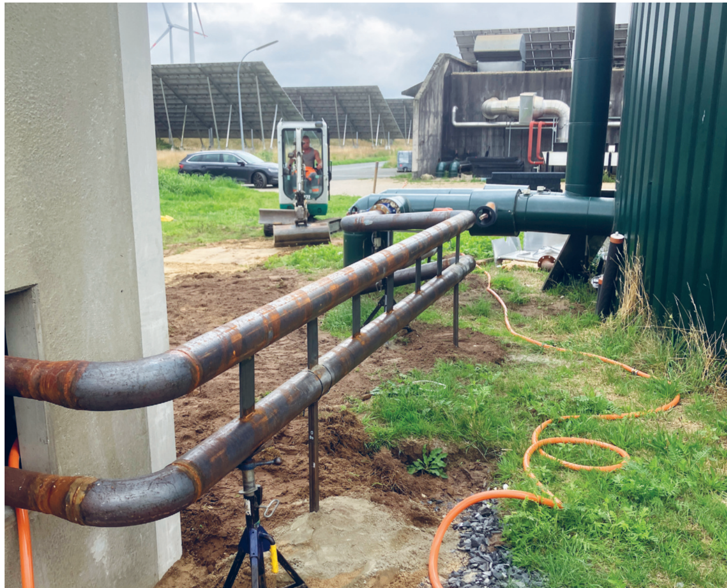
Vor- und Rücklaufleitung vom Pufferspeicher zur Übergabestation im Bioenergiepark
