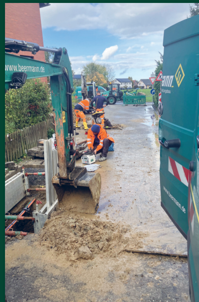
Baustellen-Einsatz: Verlegung der Trinkwasserleitung
