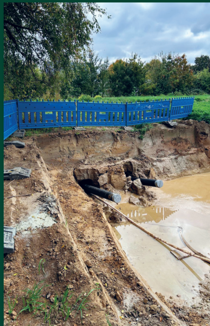
Dem Ziel näher kommende Rohreinzüge
