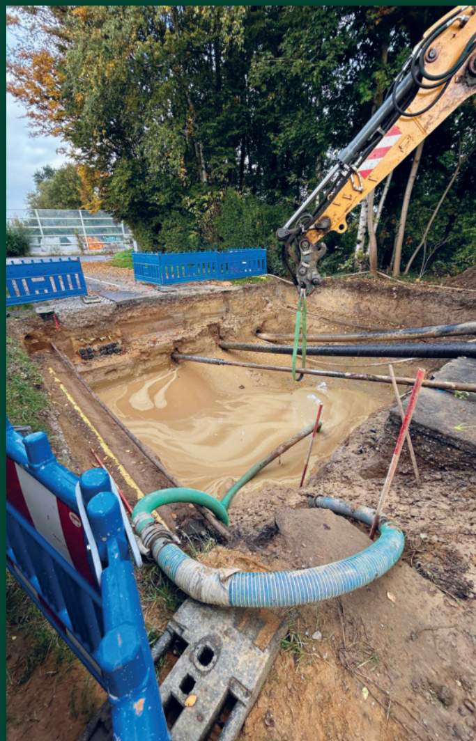
20 t Baggereinsatz zur Bohrung erforderlich gewesen
