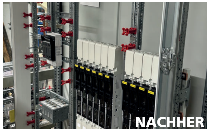
Modernisierte Niederspannungshauptverteilung
