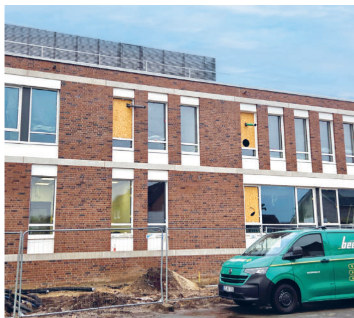
Elektroarbeiten an der Johannes-Bosco-Schule in Ibbenbüren
