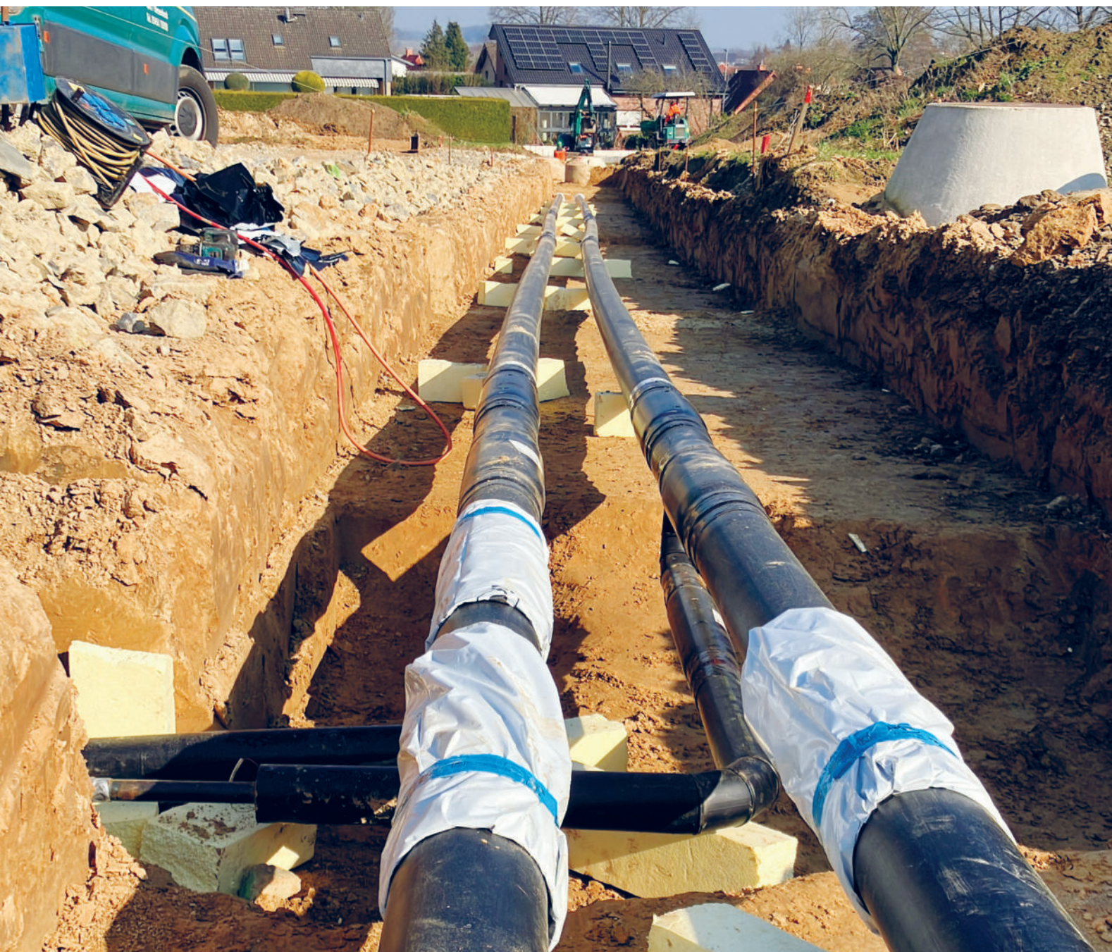
Nachisolierung der Fernwärmeleitungen
