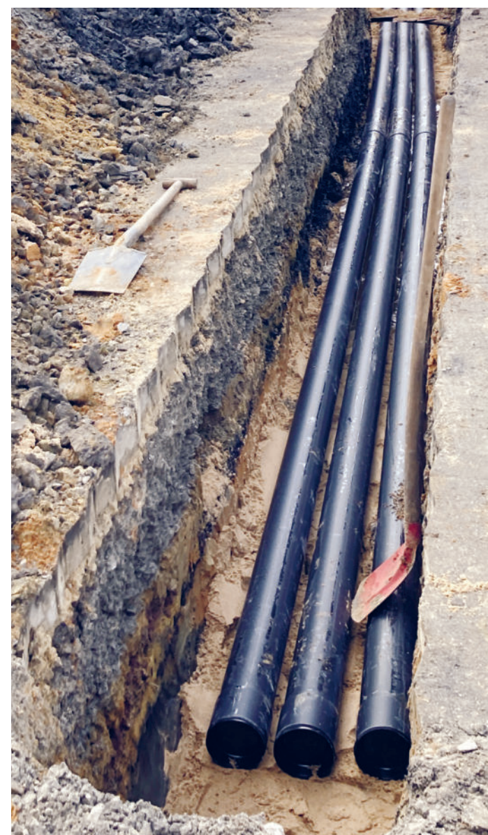
Schutzrohrverlegung in offener Bauweise
