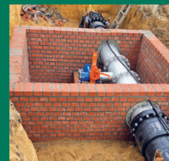
Neu aufgemauerter Schacht
