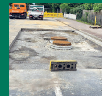
Vor dem Asphaltteinbau
