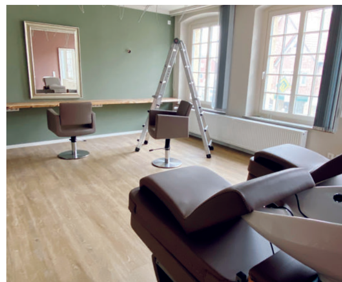
Vorbereitung der Installationen
