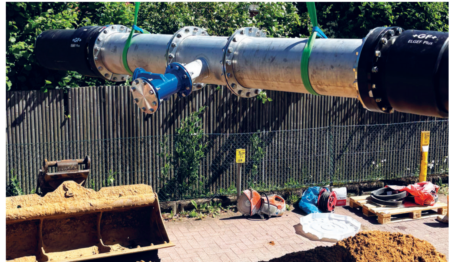
Einbau der Edelstahlteile mit Sonderflachschen
