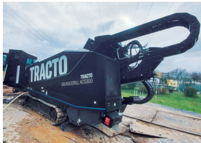
TRACTO-Anlage bei der Inbetriebnahme und den ersten Testläufen
