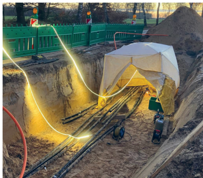
Ausgeleuchtete Baugrube für die dunkle Jahreszeit
