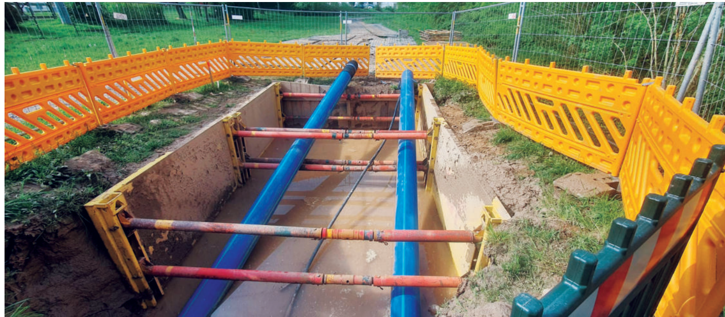
1. Bauabschnitt: Verlegung von 355-HDPE-Leitungen mittels zwei Parallelbohrungen über eine Gesamtlänge von 210 m
