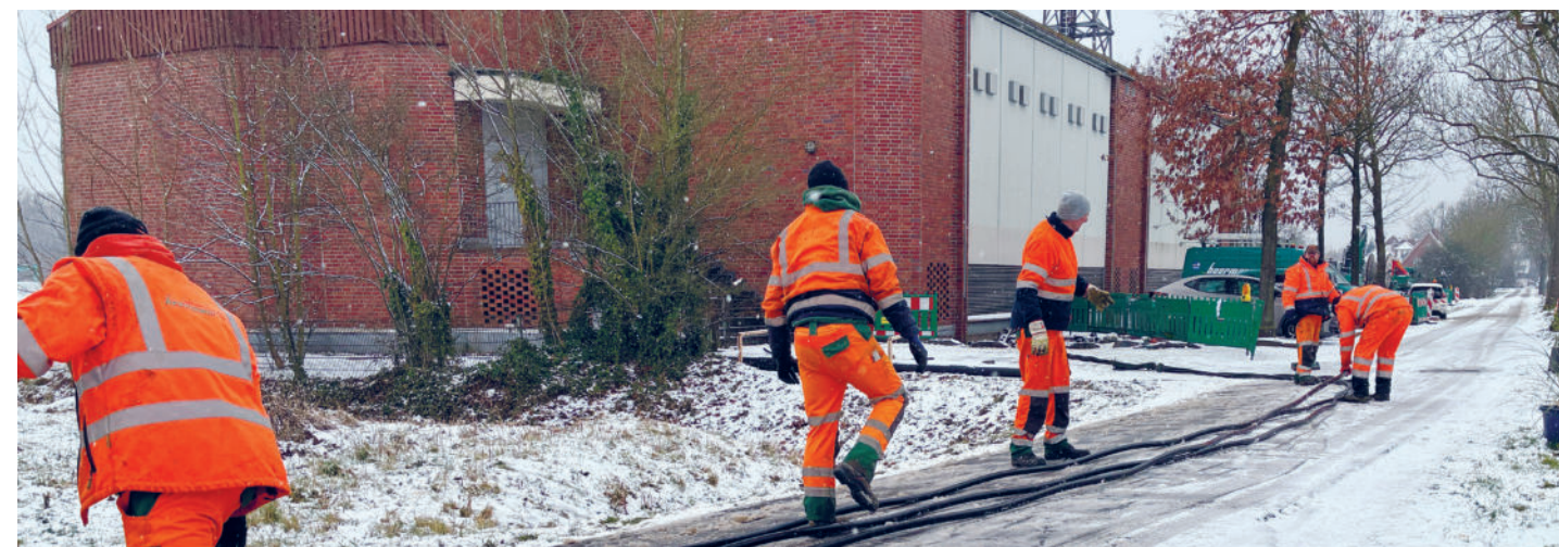
Das Team bei der Kabelverlegung
