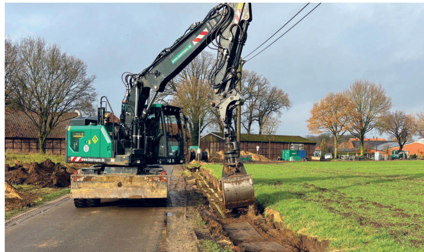
Dieter Tenberg verfüllt den Kabelgraben
