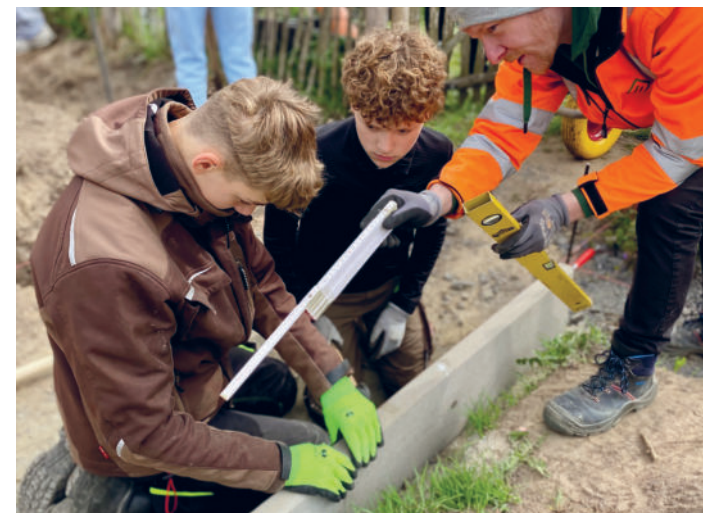
Die ersten Rasenkantensteine werden gesetzt
