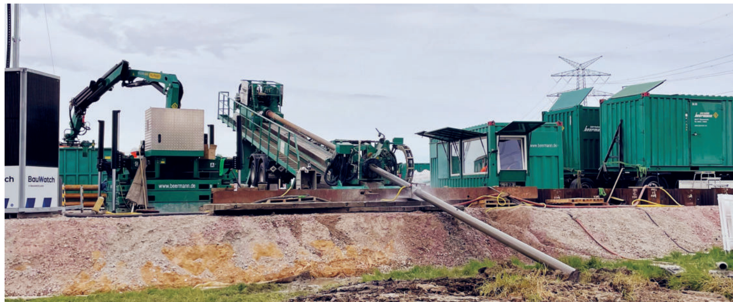
Start der Pilotbohrung
